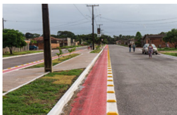
Av. Das Oliveiras depois do asfaltamento com acompanhamento da Gestão Compartilhada: obra realizada e sobra de recursos
