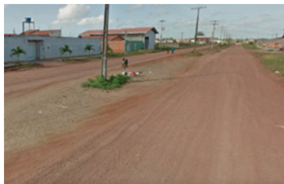
Av. das Oliveiras antes da obra de pavimentação
